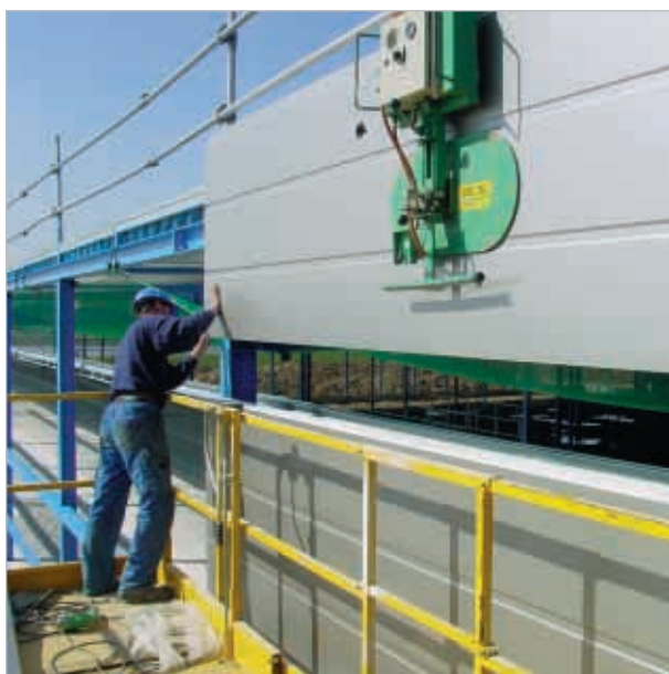
Montage met behulp van vacuüm-apparatuur
